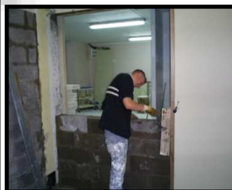
Rénovation de bâtiment (2nd oeuvre)
