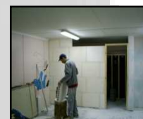
Chantier Métiers du Bâtiment
