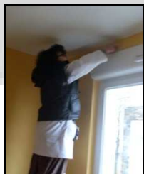
Retrait de taches de peinture sur fenêtres
