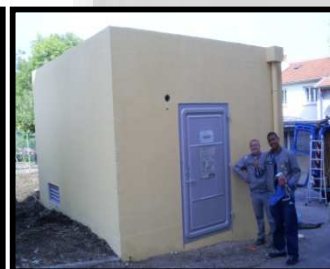
Rénovation de postes ERDF
