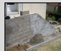
Travaux de petite maçonnerie
