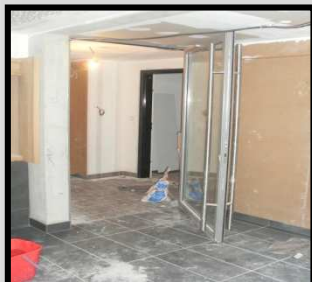
Nettoyage de logements: fin de chantier BATIGERE
