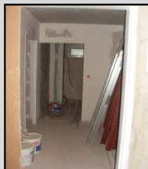
Logements neufs - chantier de Essey-les-Nancy
